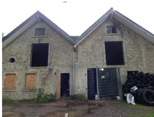
Abb. 5 Blick auf die Remise.
