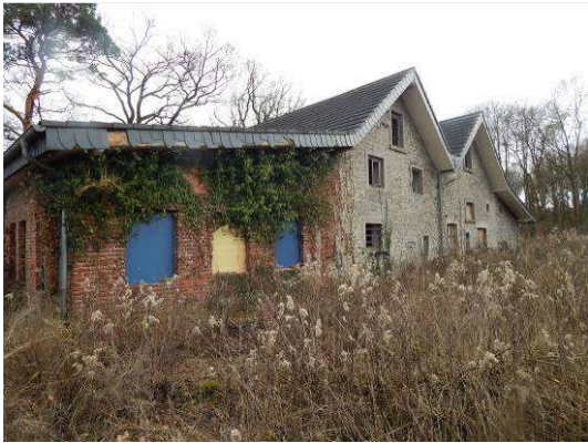
Abb. 32 Blick aus Nordwesten auf die ehemalige Remise.
