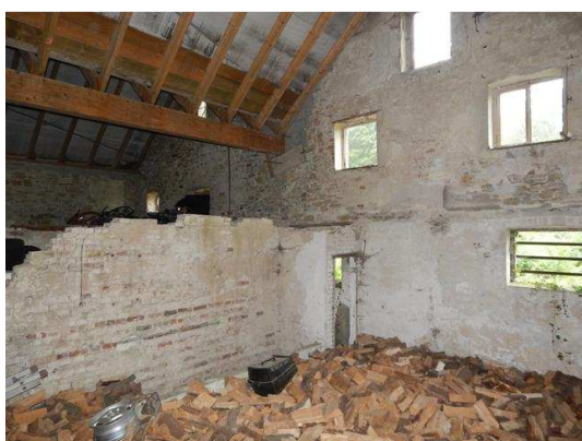
Abb. 39 Holzlager innerhalb der Remise
