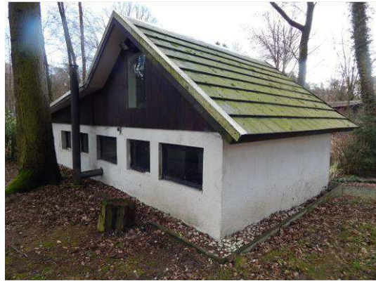
Abb. 33 Anglerhütte im Südosten des Plangebietes
