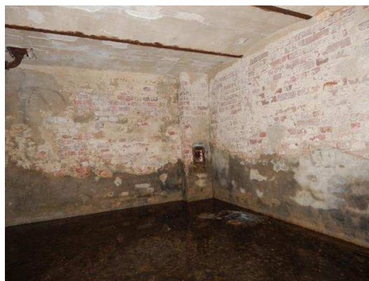
Abb. 38 Blick in den Keller der Remise
