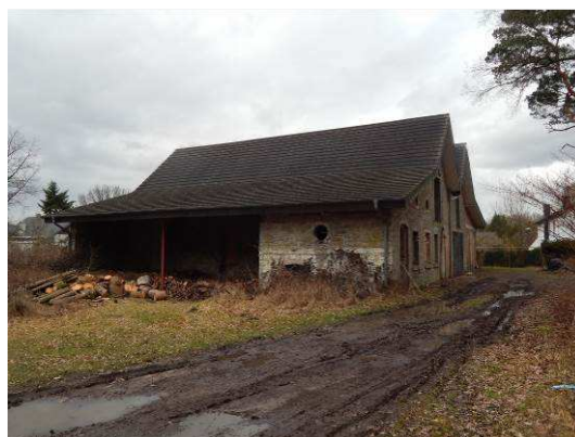
Abb. 36 Blick aus Süden auf die ehemalige Re- mise.
