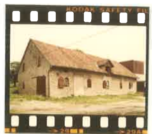
ehem. Schafstall v. W.
