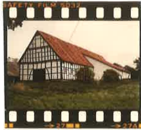
Fachwerkscheune v. SW.
