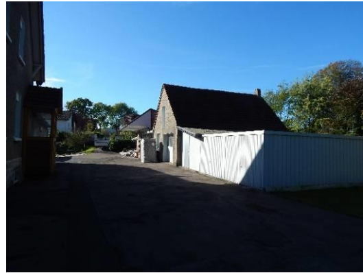
Abb. 23 Hallenkomplex mittig des Plangebiets.
