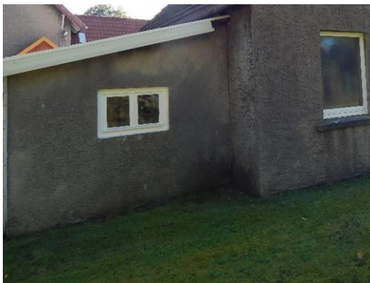
Abb. 37 Anbau in östlicher Blickrichtung.
