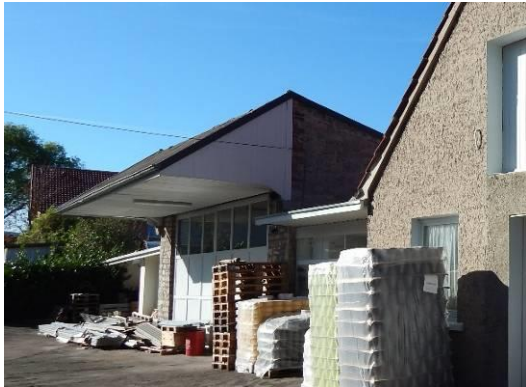
Abb. 42 Kontorähnlicher Hallenteil in südwestlicher Blickrichtung.
