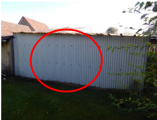
Abb. 45 Südlicher Hallenteil in östlicher Blickrichtung.
