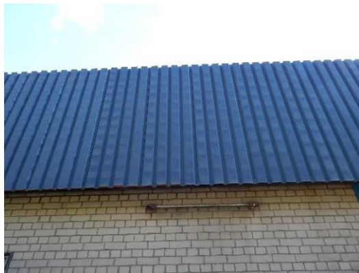
Abb. 51 Dekorplatten am Mauerwerk der Halle.
