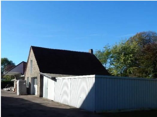
Abb. 35 Sicht auf den Hallenkomplex in südlicher Blickrichtung.
