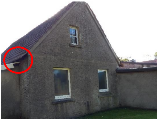
Abb. 39 Hauptgebäude in östlicher Blickrichtung. Rote Markierung stellt den Fundort des Jungvogels dar.
