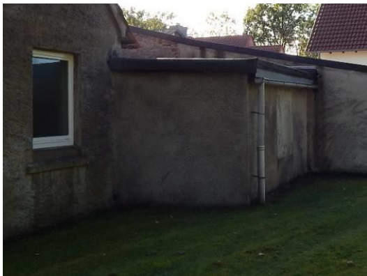
Abb. 40 Halle südlich des Hauptgebäudes in südöstlicher Blickrichtung.
