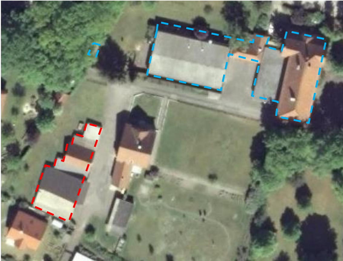
Abb. 34 Übersicht der abzubrechenden Gebäudekomplexe Legende Rote Strichlinie = Hallenkomplex Blaue Strichlinie = Gewerbekomplex mit Schulgebäude
