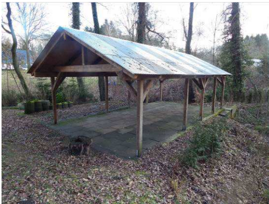
Abb. 34 Unterstand im Südosten des Plangebietes.
