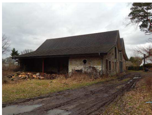
Abb. 36 Blick aus Süden auf die ehemalige Re- mise.
