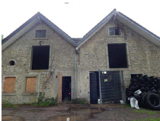
Abb. 35 Vorderansicht der Remise.
