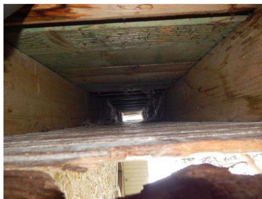
Abb. 42 Blick den giebelseitigen Dachüberstand.
