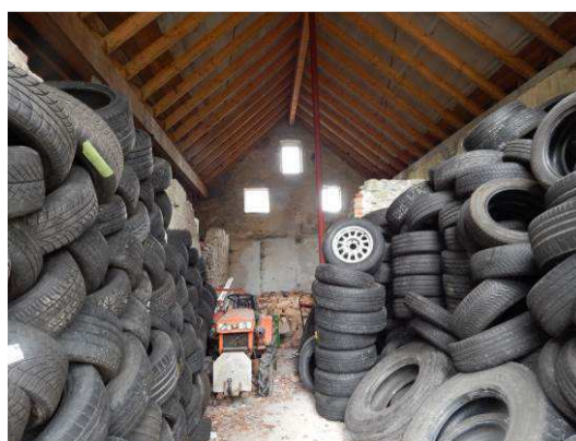
Abb. 40 Blick in das Reifenlager der Remise.
