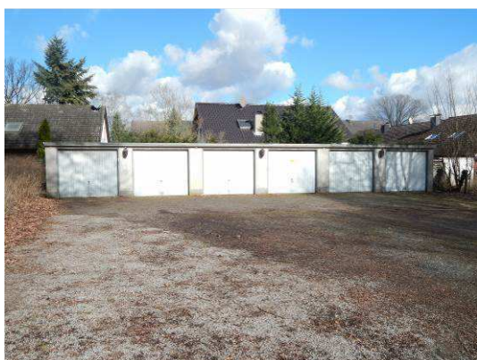
Abb. 28 Garagen im Norden des Plangebietes.
