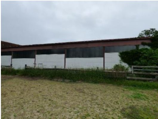
Abb. 6 Reithalle im Plangebiet.
