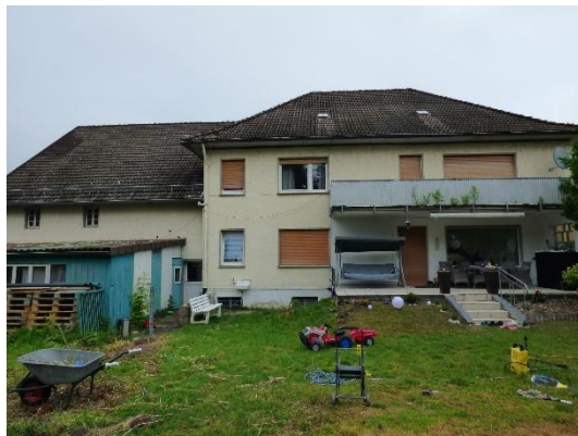
Abb. 45 Südansicht des Wohnhauses.
