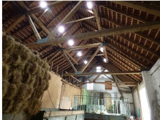
Abb. 34 Innenansicht der Scheune.
