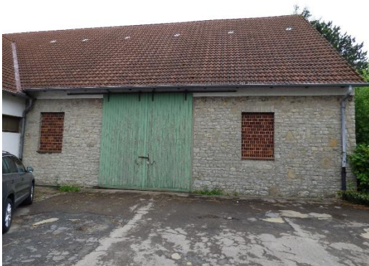
Abb. 37 Westansicht der Scheune.
