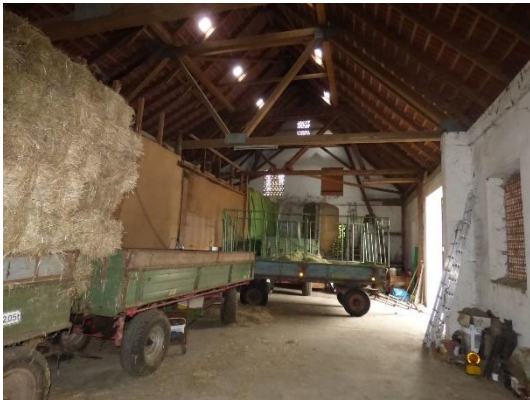
Abb. 35 Innenansicht der Scheune.
