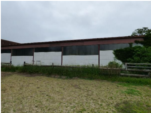
Abb. 6 Reithalle im Plangebiet.
