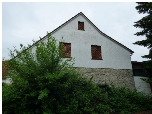
Abb. 38 Südansicht der Scheune.
