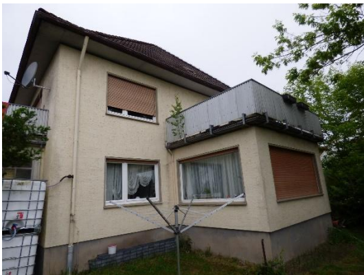
Abb. 44 Ostansicht des Wohnhauses.
