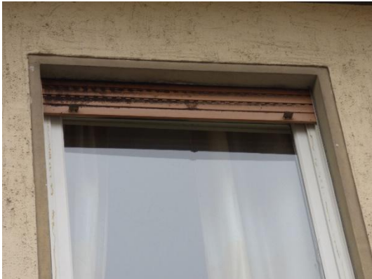
Abb. 50 Rollladenkasten an der Nordseite des Wohngebäudes.
