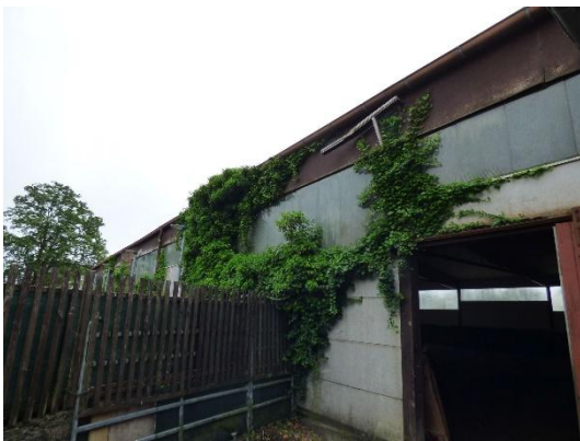
Abb. 40 Nordansicht der Reithalle.
