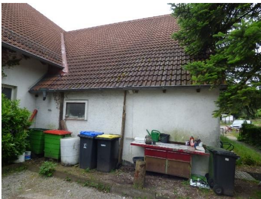
Abb. 31 Nordansicht des Gebäudes.
