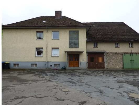
Abb. 43 Nordansicht des Wohnhauses.
