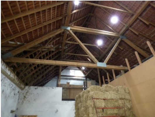
Abb. 33 Innenansicht der Scheune.
