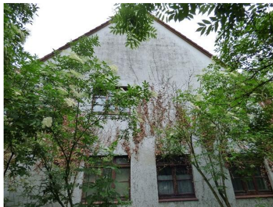
Abb. 32 Nordansicht des Gebäudes.
