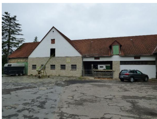
Abb. 28 Südansicht des Gebäudes.
