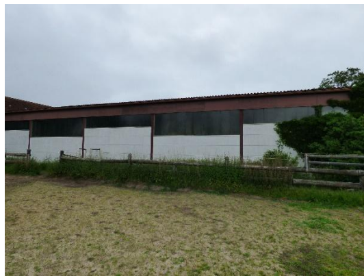
Abb. 41 Südansicht der Reithalle.
