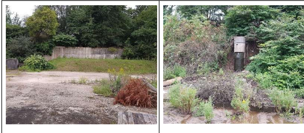
Abbildung 2: Stützmauer und Sickerwasserschacht an der südlichen Grundstücksgrenze
