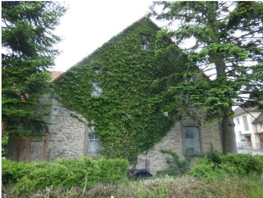
Abb. 29 Westansicht des Gebäudes.
