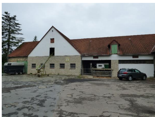
Abb. 28 Südansicht des Gebäudes.
