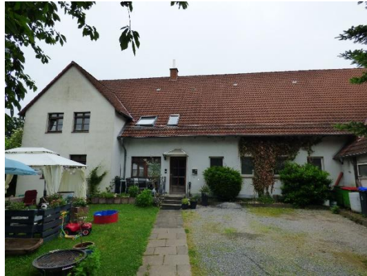
Abb. 30 Westansicht des Gebäudes.
