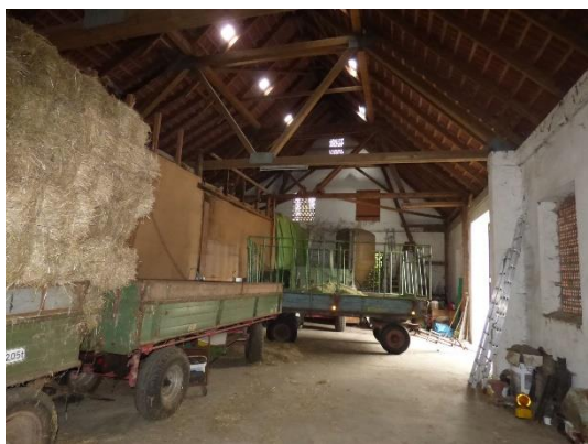
Abb. 35 Innenansicht der Scheune.
