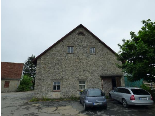
Abb. 42 Westansicht des Wohnhauses.
