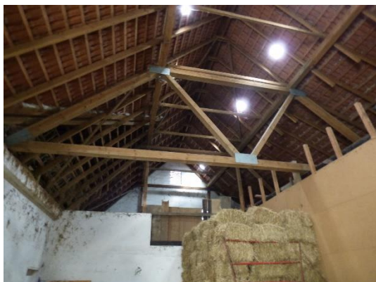
Abb. 33 Innenansicht der Scheune.
