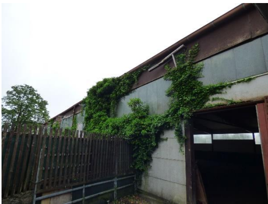
Abb. 40 Nordansicht der Reithalle.
