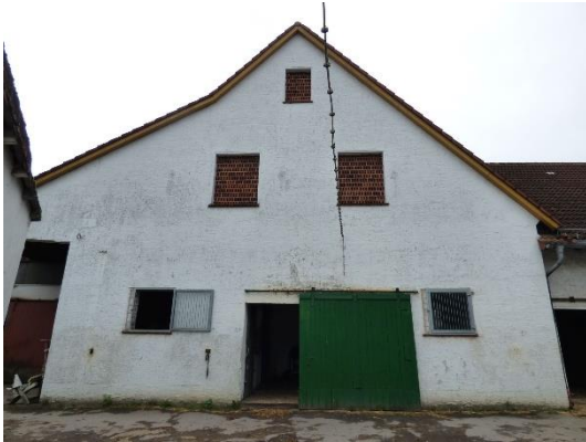
Abb. 39 Nordansicht der Scheune.
