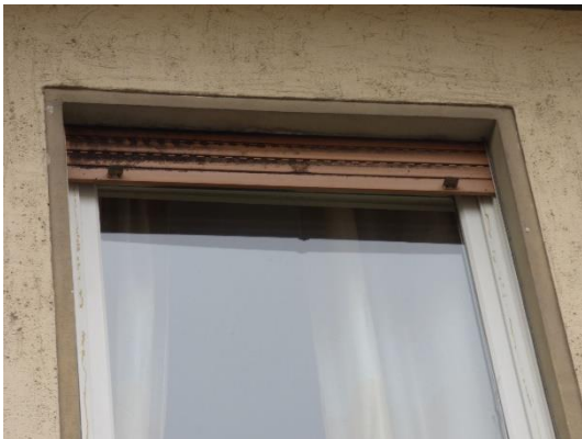
Abb. 50 Rollladenkasten an der Nordseite des Wohngebäudes.
