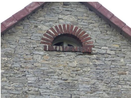
Abb. 46 Fenster nische am Giebel an der Westseite des Wohnhauses.
