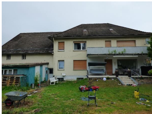
Abb. 45 Südansicht des Wohnhauses.
