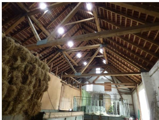
Abb. 34 Innenansicht der Scheune.
