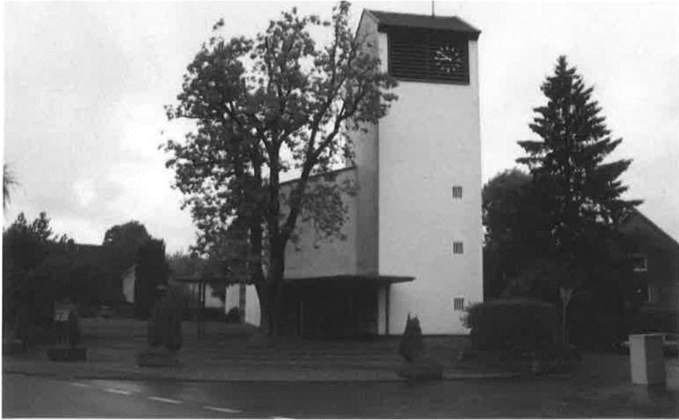
Eingangsfassade, 2009 (Arbeitsfoto LWL-DLBW)
