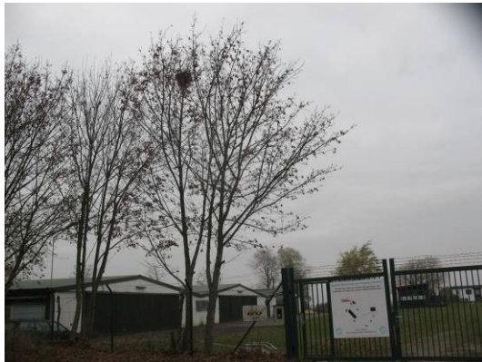
Abb. 24 Blick von Süden auf das Flugplatzgelände.
