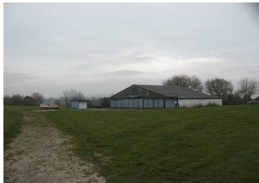
Abb. 21 Blick von Nordwesten auf Gebäude des Flugplatzes.
