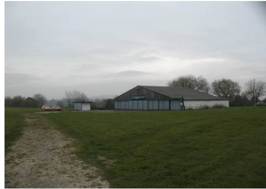
Abb. 22 Gebäude auf dem Flugplatzgeländes.
