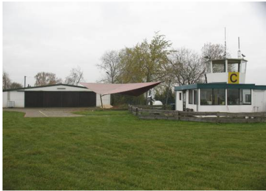
Abb. 21 Gebäude auf dem Flugplatzgeländes.
