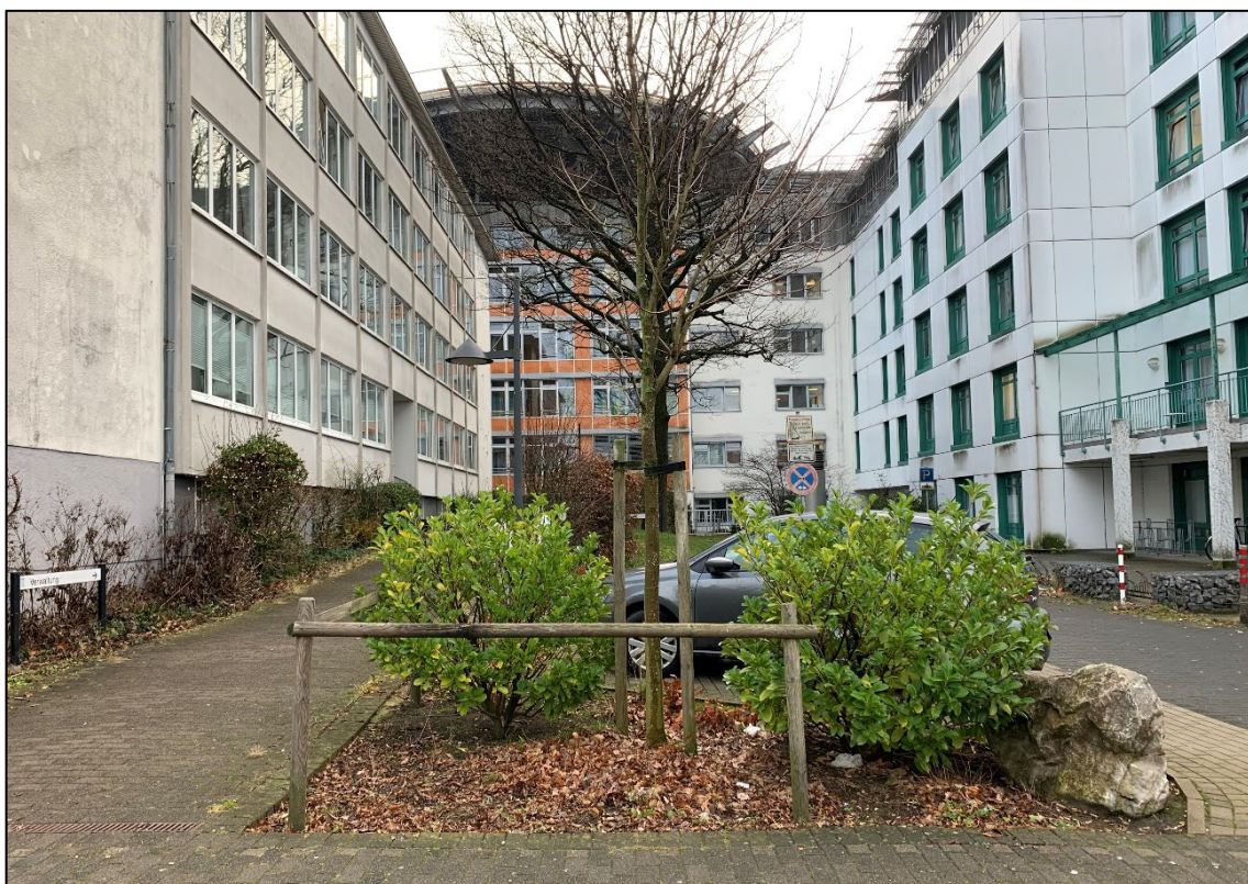
Blick auf Verwaltungsgebäude (links), Nordflügel Bauteil A (Mitte) und Westflügel (rechts)
