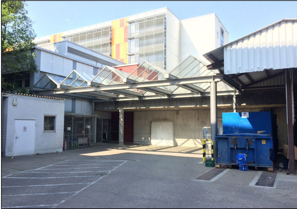
Blick in den Innen- / Betriebshof
