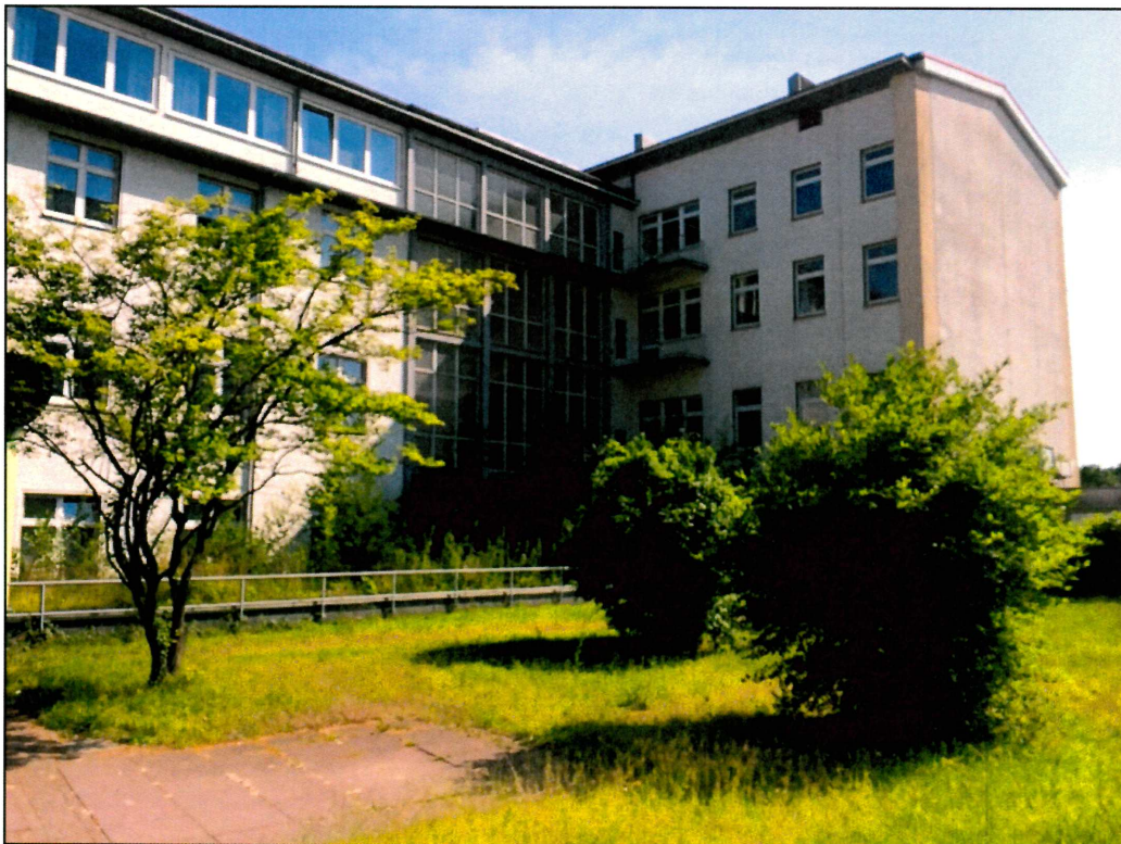
Blick in Richtung Haus II in den Innenhof im 1.UG (ebenerdig zur Urologischen Ambulanz) oberhalb des 2.UG (Institut für Mikrobiologie und Laboratoriumsmedizin)
