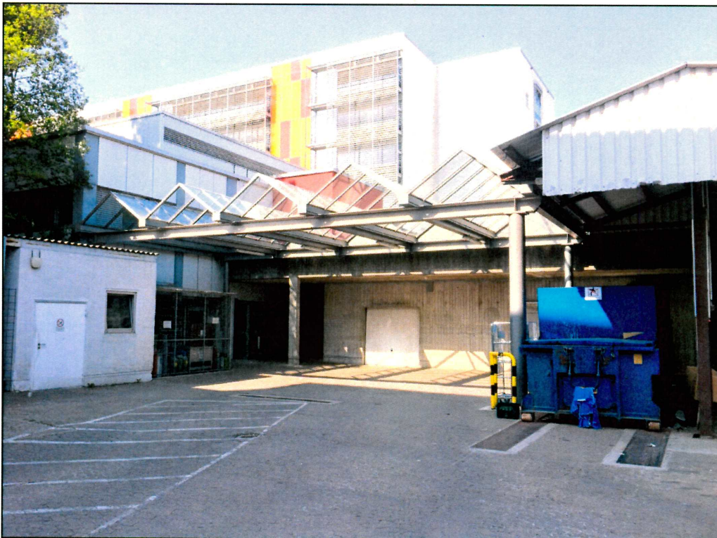
Blick in den Innen- / Betriebshof
