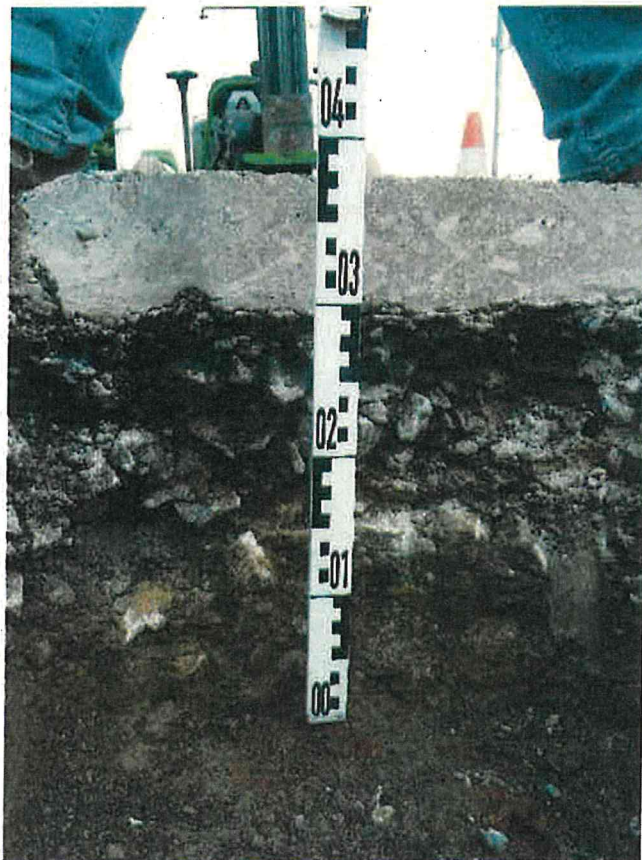
Abb. 13: Schurf 1: Schichtenaufbau des Oberbaus
