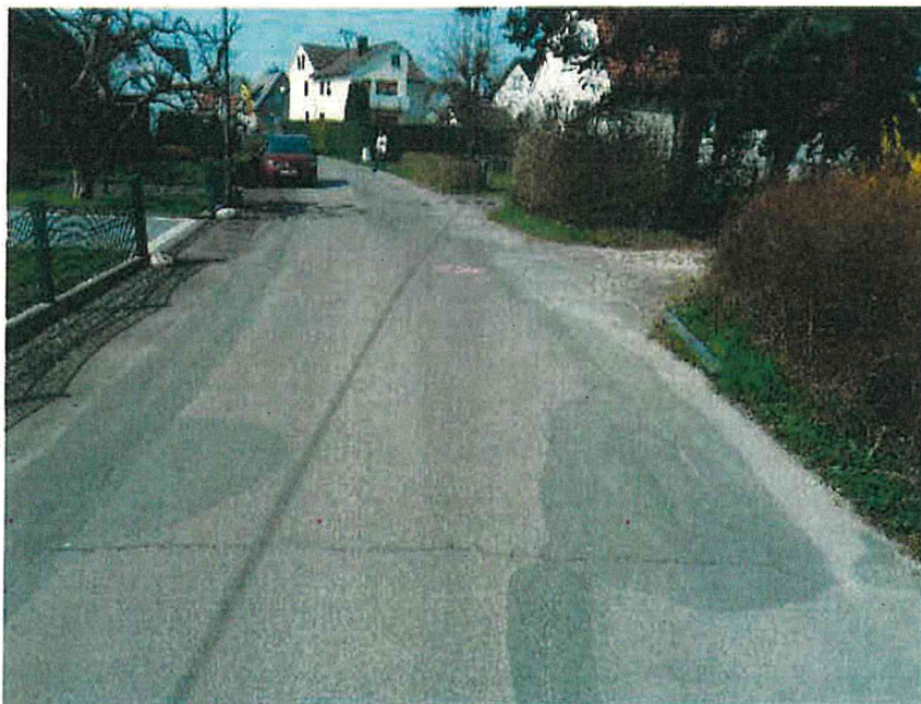
Abb. 6: Ca. 3,70 m breite Fahrbahn mit südwestlich (links) vorhandenem, provisorisch asphaltiertem Verbreiterungsbereich (NKA 8555 043 nach 8555 035, ca. Station 120 m)
