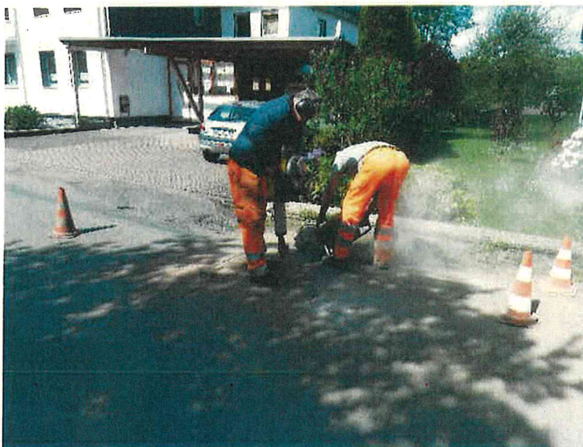
Abb. 10: Schurf 1: Auftrennen und Aufstemmen der Asphaltbefestigung
