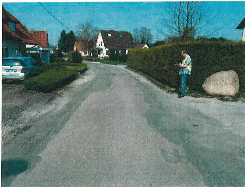
Abb. 7: Visuelle Beurteilung und Dokumentation der Zustandsmerkmale der Oberfläche (NKA 8555 043 nach 8555 035, ca. Station 0 m)
