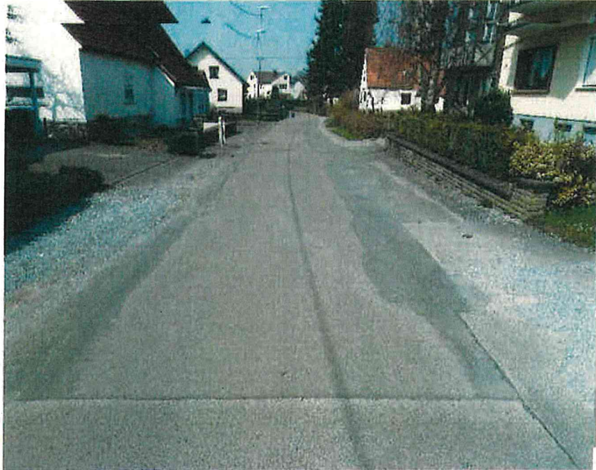
Abb. 5 Ca. 3,70 m breite Fahrbahn mit südwestlich (links) vorhandenem, provisorisch asphaltiertem Verbreiterungsbereich (NKA 8555 043 nach 8555 035, ca. Station 50 m)
