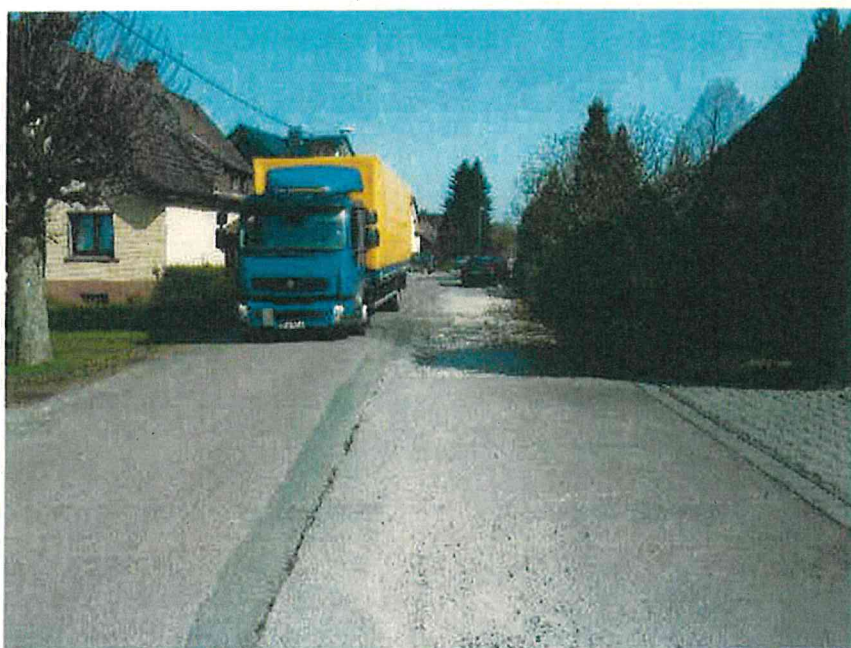
Abb. 17: Im Begegnungsfall mit einem Lkw ist aufgrund der geringen Breite der Fahrbahn von ca. 3,05 m ein Ausweichen auf den unebenen Verbreiterungsbereich notwendig
