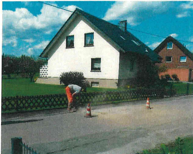
Abb. 14: Schurf 2: Auftrennen der Asphaltbefestigung
